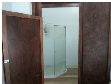
Salle de maquillage avec douche en cours de construction
