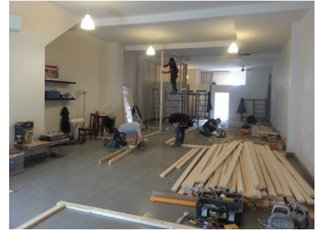
Jour 1 : Début des travaux
