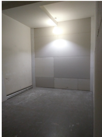
Jour 8 : Studio construit, à compléter le plancher, le limbo et la grille d'éclairage
